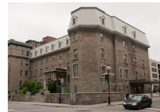
L'Hôpital général rue Saint-Hubert en 2013.
